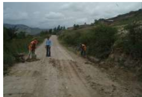
Supervisión de actividad de limpieza de cunetas y bacheo tramo AA.HH. Primavera - Yanamilla
