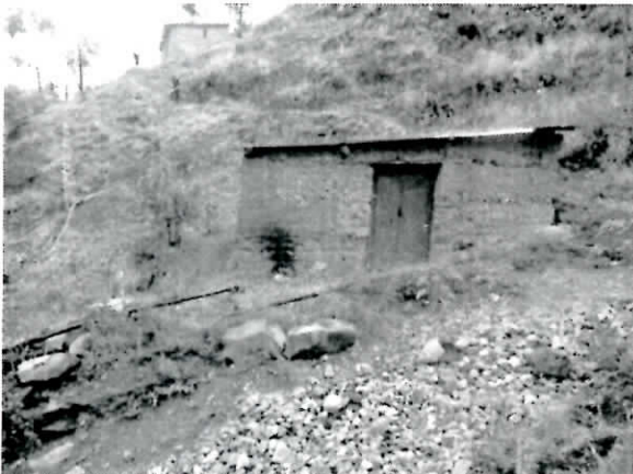
Intervención a Viviendas construidas en zona de riesgo
